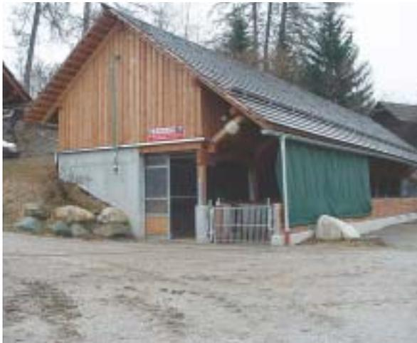
Die bauliche Ausführung ist – in kurzen Worten gefasst – wie folgt: Offenfrontstall – Kaltstallsystem, Fundament und Wände bergseitig in Dichtbeton ausgeführt, die Lagerräume mit starkem Lärchenholz gezimmert, Lärchen-Tramdecke eingezogen. Das Dach ist als robustes Lärchen-Bretterdach ausgeführt, dreifach gedeckt.
